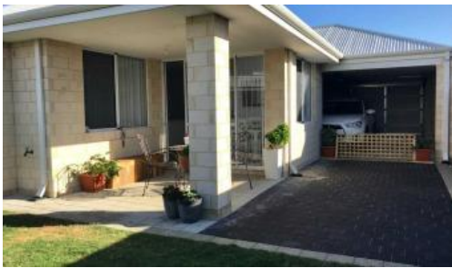
30 Etendue Cres, Eglinton
